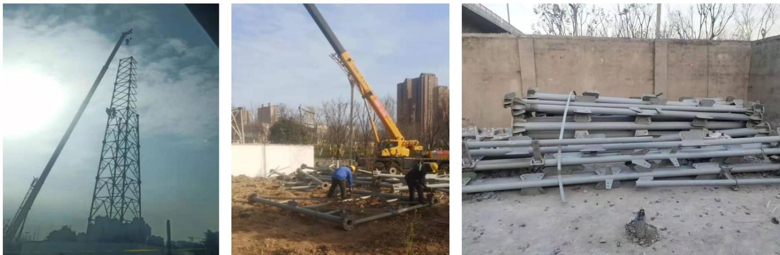
随着新建GSM-R基站网络服务质量通过动态测试以及其他通信设备业务切割入网后，标志着新设备已正式投用，原有设备可以拆除。经检测，在地铁十四号线开通运行后，原有铁塔在地铁运行产生的震动过程中逐渐向高铁桥梁侧倾斜，存在重大安全隐患，既有铁塔拆除已迫在眉睫。为此，项目部积极协调西安通信段、高铁基础设施段等配合单位，对拆除方案进行反复论证，方案确定后，于11月中旬上报了施工计划。西安局集团公司批复的施工时间12月24至26日，正是西安疫情封城时期，全体施工人员持工作证明、48小时内核酸证明，经过必要的消杀和防疫用品检查后方可进场施工，保施工安全，更保防疫安全。全体施工人员历时3天，在12月26日18时顺利完成了对既有铁塔的拆除工作，彻底排除了影响高铁运行的安全隐患。至此，徐兰高铁通信基站及其配套设施迁建工程完成了所有重难点工作，为接下来的收尾工作奠定了良好的基础。
