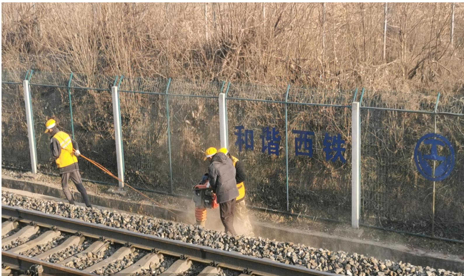
侯西线通信干线电缆大修项目开工以来，公司调集精干人员，顶风雪、冒严寒，克服不利条件，全面展开项目施工。于12月9日完成所有电缆敷设任务，共计开挖缆沟14.8公里，敷设电缆约16公里，砌筑电缆井13个，安装区间电话13套。
