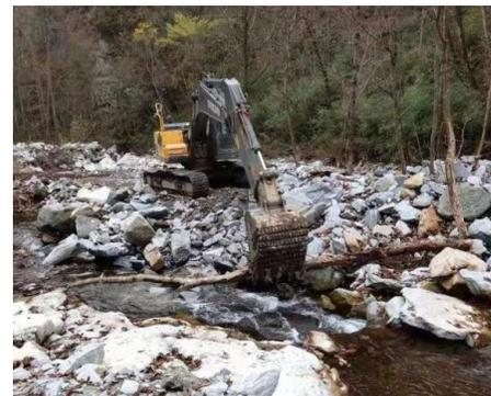
道路修复施工期间，项目部加强施工管理，牢固树立“安全第一、预防为主”的思想，安全责任落实到人。施工现场配备挖掘机及装载机等施工机械，项目经理亲自指挥，并派专职安全员盯控，摧毁路段集中展开挖填、土方倒运、路面平整、河道修复等施工作业，历经5天连续施工作业，投资五万余元，让“天堑变通途”，解决了困扰施工的一大难题，为后续施工材料转运、设备安装以及各站段、施工单位巡检及维修提供了便利的条件，更为当地村民出行提供了一条重要通道。
