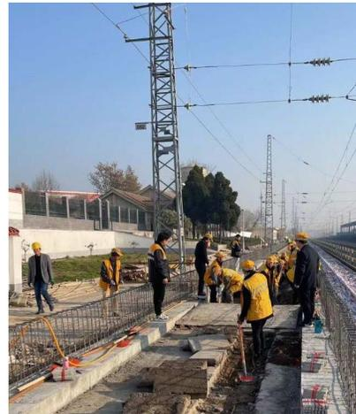
侯西线韦庄-醴醐-坞坨共计开挖缆沟11公里，敷设电缆12.6公里，砌筑手孔13个，安装区间电话10部。截止目前，该项目完成电缆敷设约80%，开挖缆沟约85%。计划于12月上旬全面完成施工任务。
